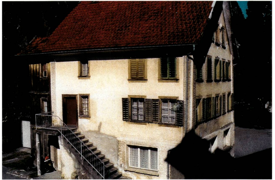
Abb. 12: Haus im Reussboden, Amsteg, Süd- wand von 1999 nach Amsteg. Quelle: Josef Dittli- Berther, Amsteg
