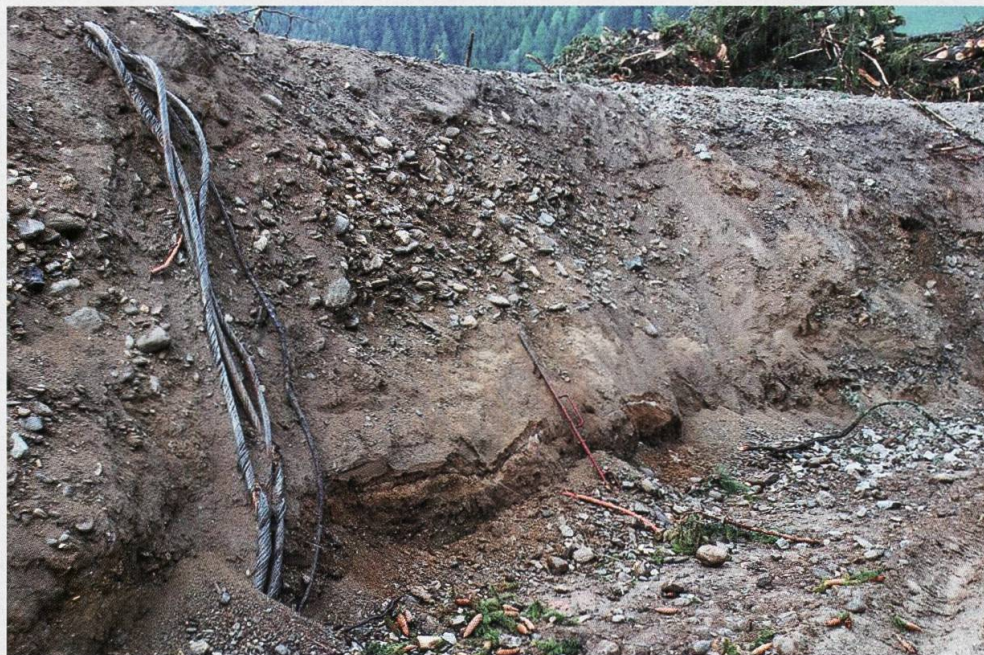
Abb. 19: Andermatt, Baubegleitung Hotel «The Chedi». Das Nord-west-Profil in der Baugrube des Hotels weist sandig-siltige Ablagerungen und dünne dunkle Schichtbändchen im unteren Bereich auf, darüber folgen mächtige Geröllablagerungen.
