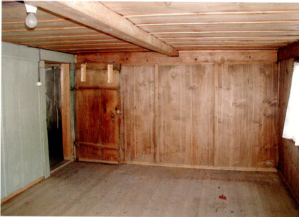
Abb. 20 Bretterwandtäfer mit Deckleisten in der Schlafkammer im zweiten Obergeschoss der Wohnung Ost.
