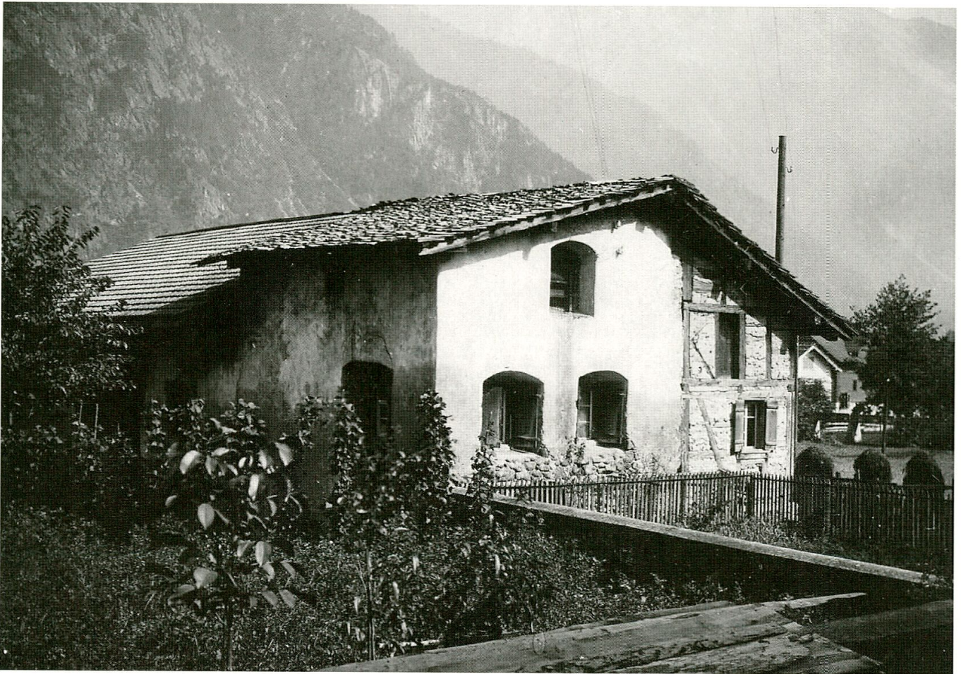
Abb. 12 Das Wohnhaus Talweg 10 mit dem turm- artigen Hausteil auf einer Ansicht um 1920.
