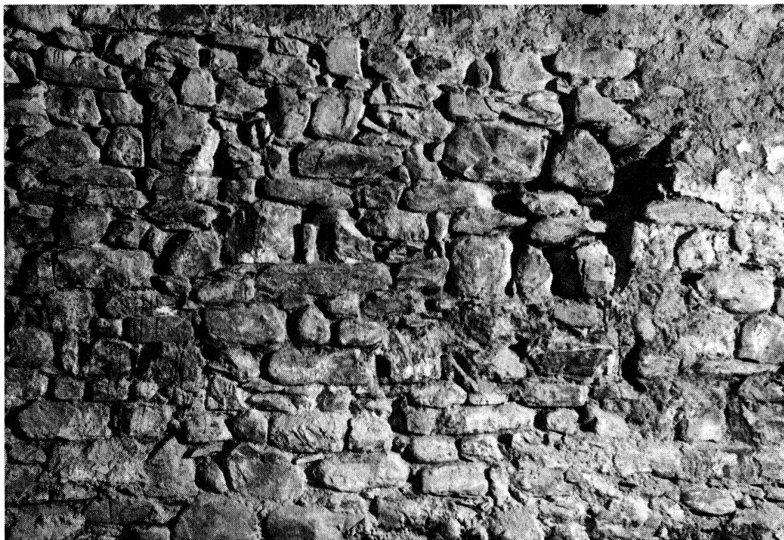
31 Ausschnitt aus dem Mauerwerk der neuen Schiffsüdmauer (Schiffverbretterung).
