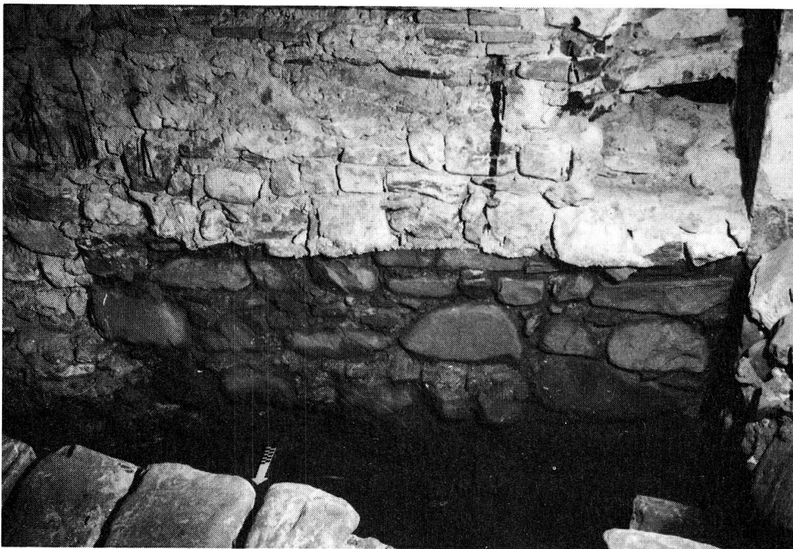
10 Gotische Chorsüdmauer über dem Fundament der älteren Beinhaus-Nordmauer.
