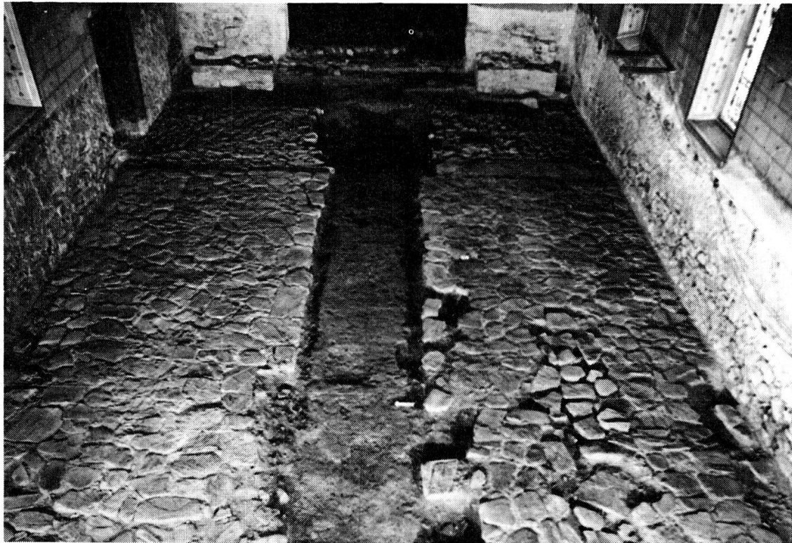
37 Uebersicht von der Empore über das Steinbett (Bodenunterlage) von 1755.
