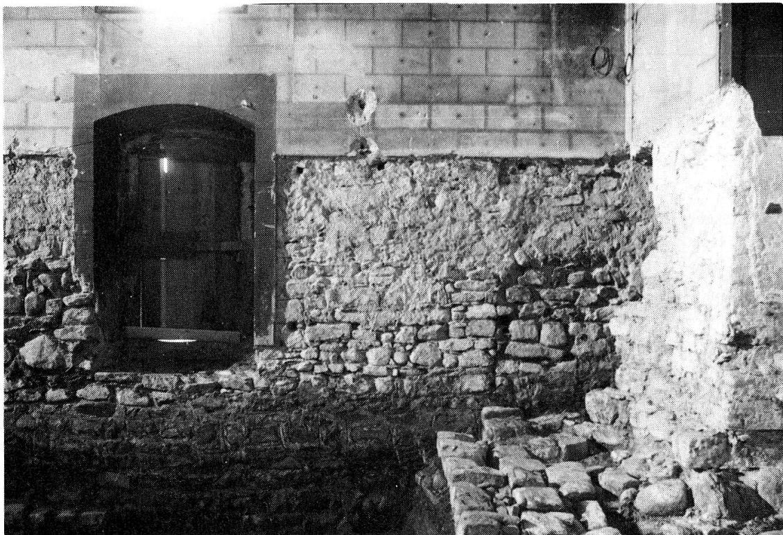
12 Schiffnordmauer im Bereich der Vorchorzone. Rechts der Türe eine barocke Mauererneuerung (von 1769), die das rechts danebenliegende Mauerwerk der ersten Chorumbauphase stört.
