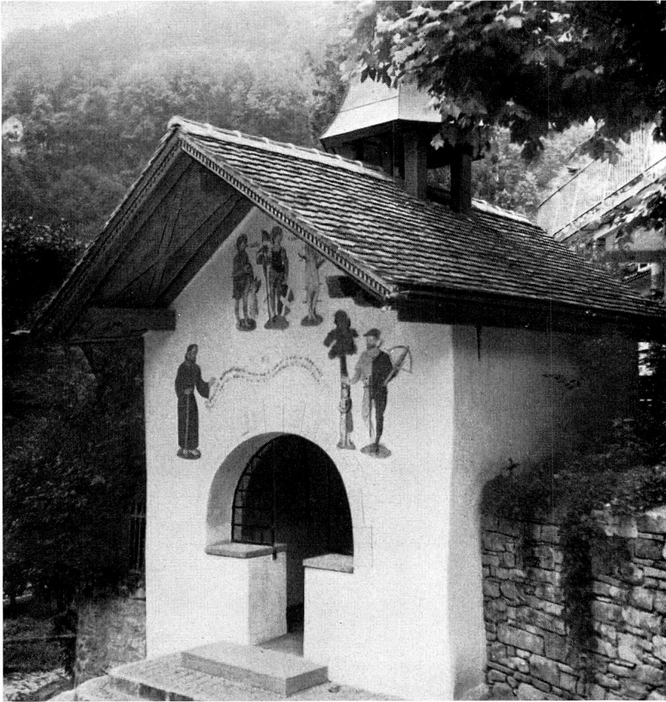
Die renovierte Tellskapelle am alten Saumweg nach dem Klausen.
