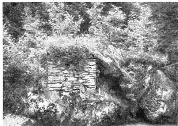
Fig. 28. Jetziger Zustand eines Widerlagers der einstigen Meitschlingerbrücke.
