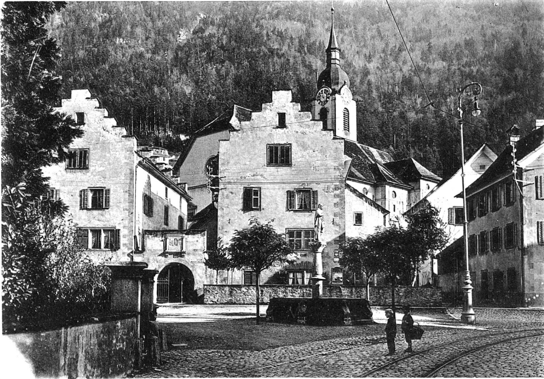
Der alte Fremdenspital in Altdorf, erbaut ca. 1550, mit dem St. Josephsbrunnen
