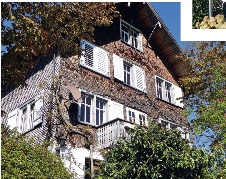
Weitere Chalet-ähnliche Häuser in Meilen: Justrain, Toggwilerstrasse, Schwabachstrasse.
