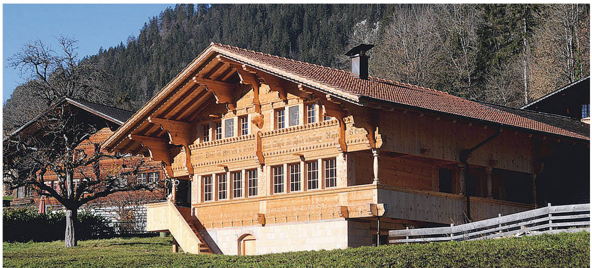
Neu erbautes Simmentaler Chalet im ursprünglichen Stil.
