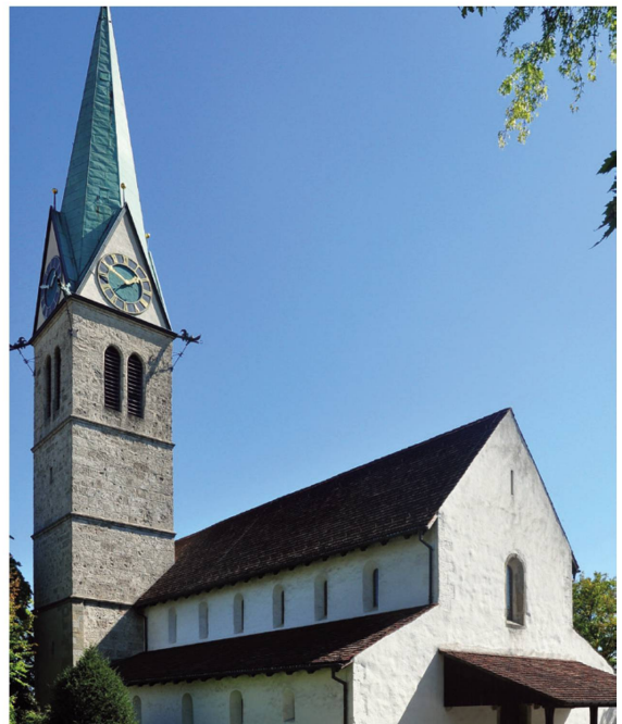
Die Kirche St. Arbogast in Oberwinterthur wurde mit einem stabilisierenden Chorflankenturm gebaut.
