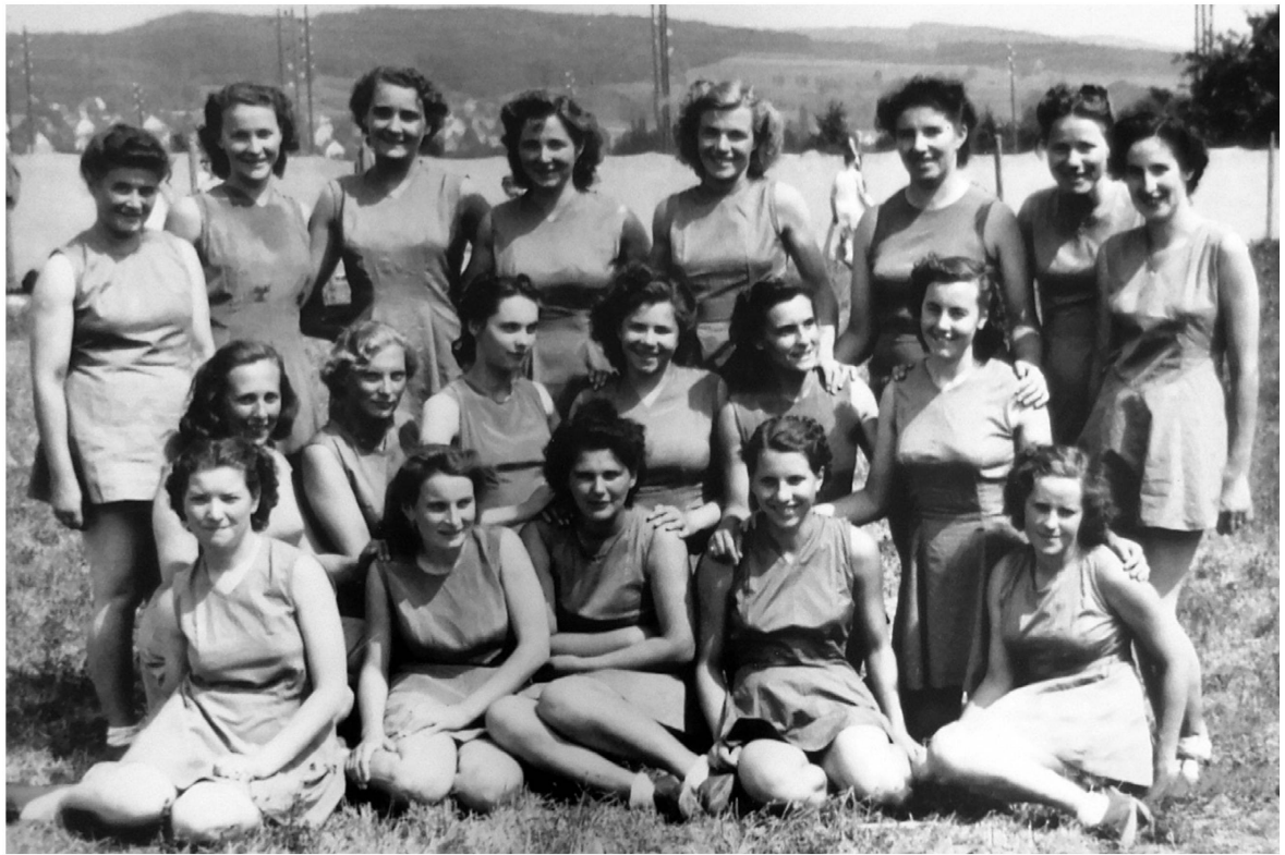
Der Damenturnverein von Meilen in den 1920er Jahren.
