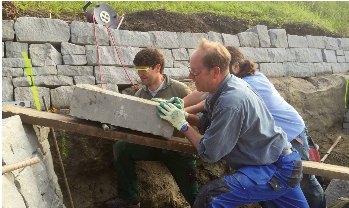
Freiwillige bauen im Mai 2016 eine Natursteinmauer im Schiltrain, einem kommunalen Naturschutzobjekt.
