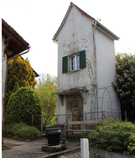
Eines von zwei alten Trafohäuschen, die in Meilen noch erhalten geblieben sind. Es steht an der Schwabachstrasse.
