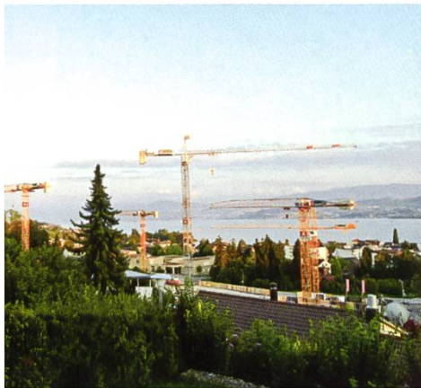
Vor allem im Jahr 2011 wurde in Meilen viel gebaut, wie die zahlreichen Krane zeigten.
