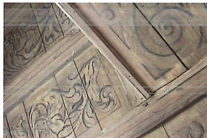
mitte unten: Ausschnitt aus der bemalten Balkendecke im Gang des Obergeschosses.
