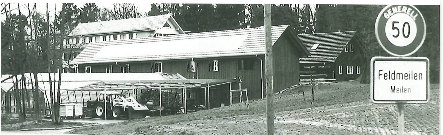
Gärtnerei mit Glastreibhäusern vor dem Umbau.
