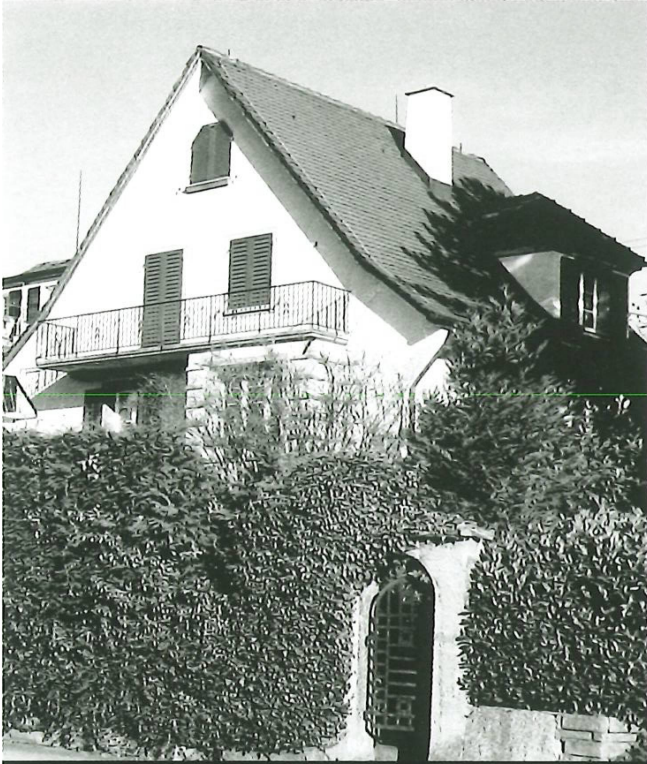
Seestrasse 15, von Südosten.
