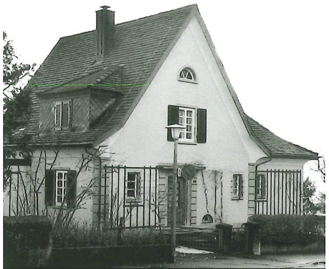
Pfannenstielstrasse 68, von Nordosten.
