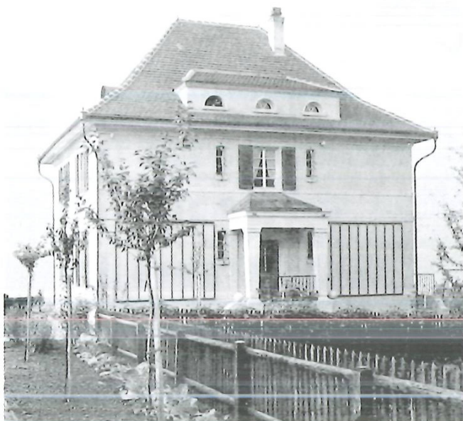
Bruechstrasse 146, von Norden.
