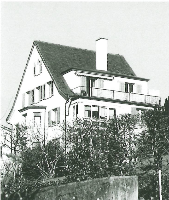
Teienstrasse 98, von Südosten, zum Abbruch vorgesehen.
