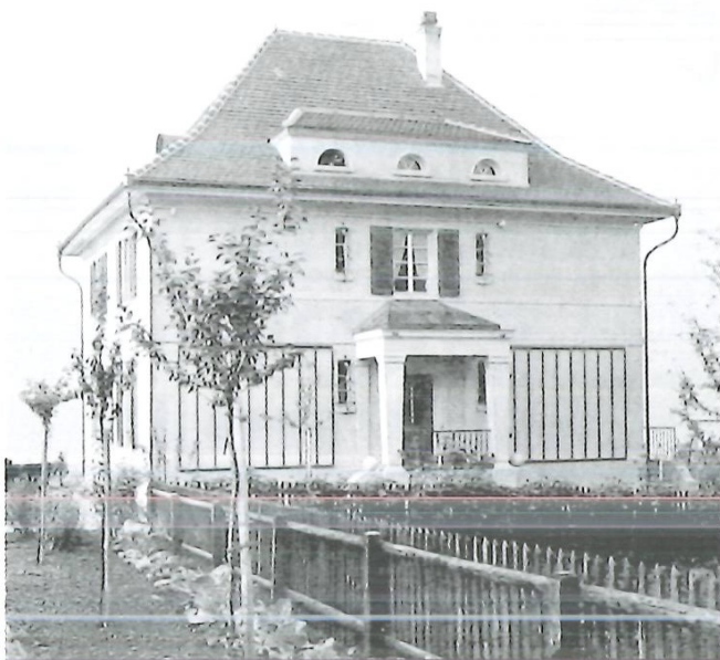
Bruechstrasse 146, von Norden.
