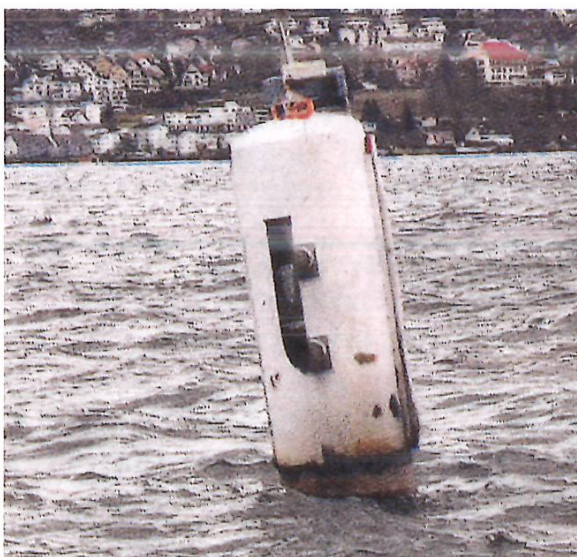
Geneigter Leitpfahl und rechts: Alte Ländeanlage.
