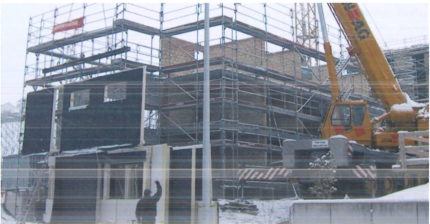
Montage der industriell gefertigten hölzernen Fassadenelemente.
