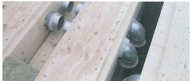
Vor der Montage wurden alle notwendigen Installationen in die Elemente eingebaut – hier Lüftungsrohre in den Deckenelementen.
