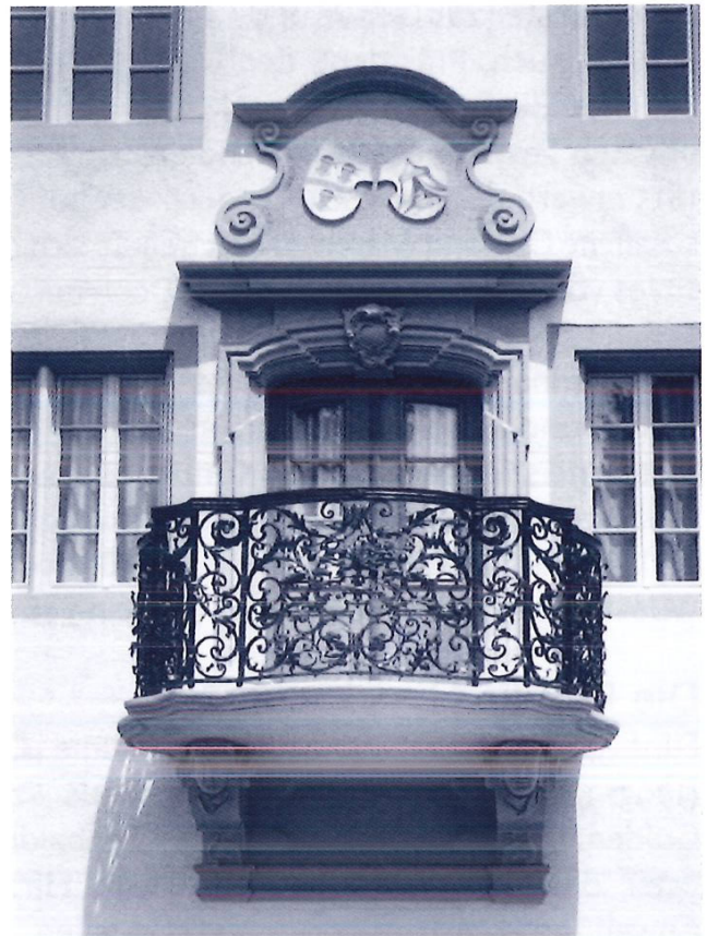
Renovation 2002/03, Aussenansichten. links: Balkon, Mitte: Portal, rechts: Ansicht von Süd- westen.
