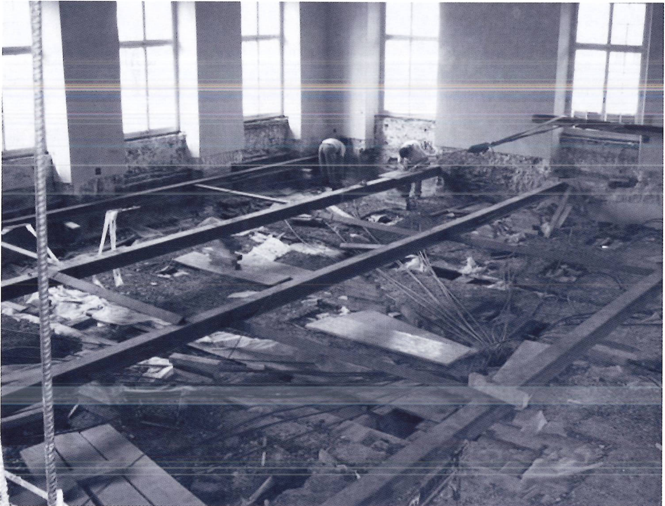
Stahlstreben während der Bauarbeiten.
