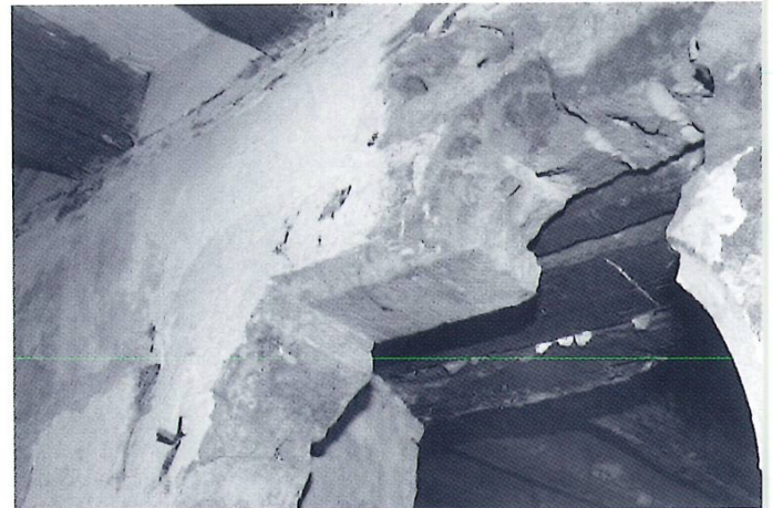
Sturz der freigelegten gotischen Schulterbogentür im Erdgeschoss.
