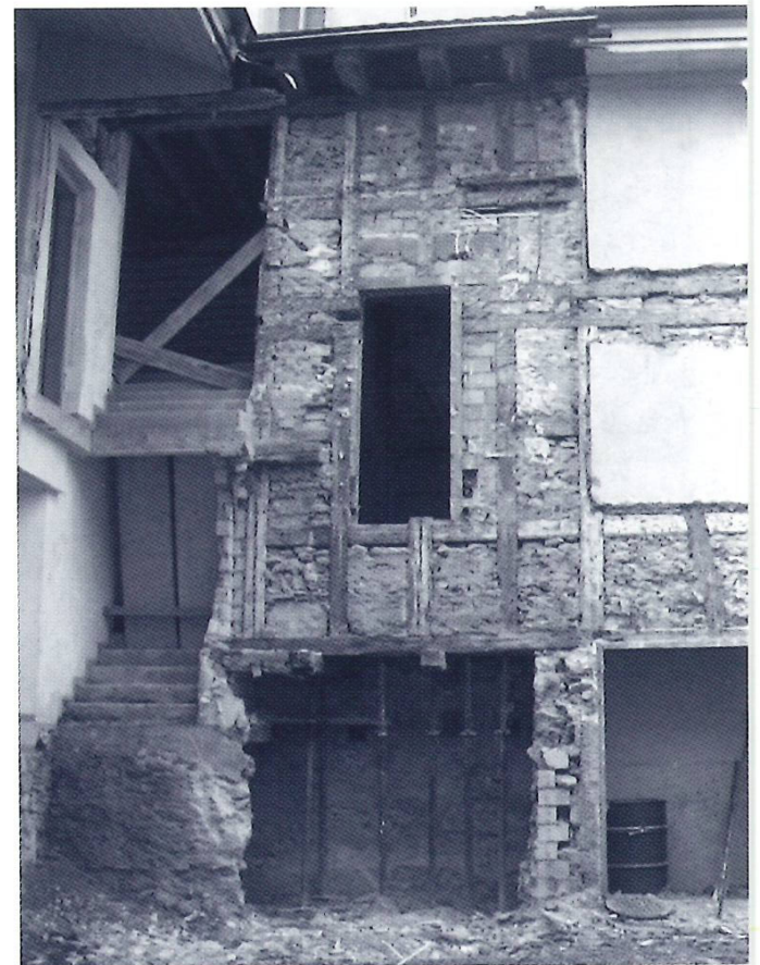
Freigelegtes Fachwerk gegen Norden.
