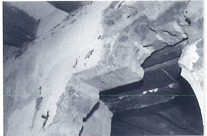
Sturz der freigelegten gotischen Schulterbogentür im Erdgeschoss.
