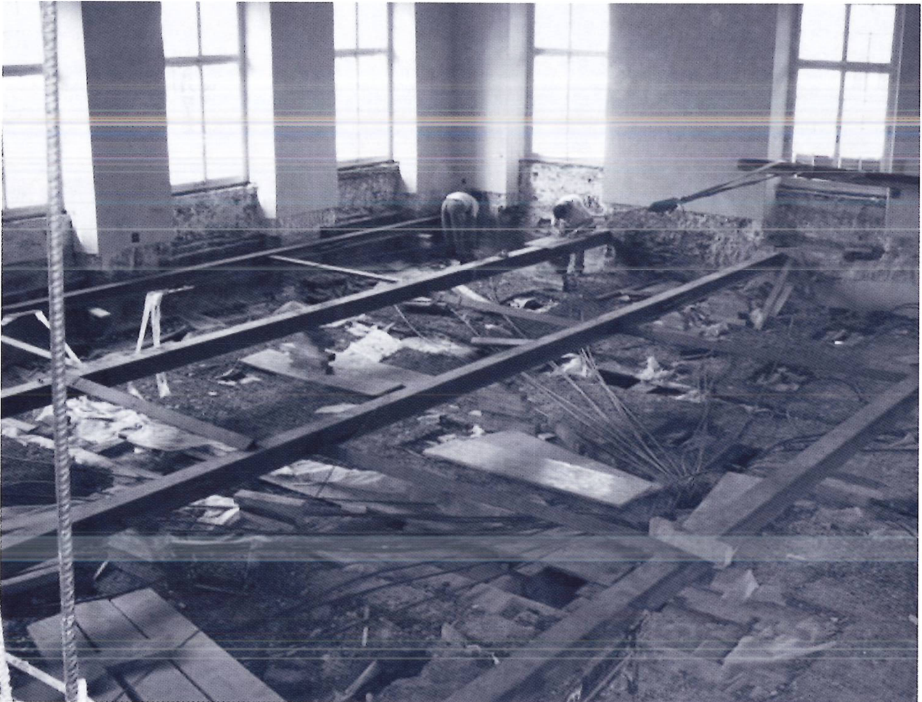
Stahlstreben während der Bauarbeiten.
