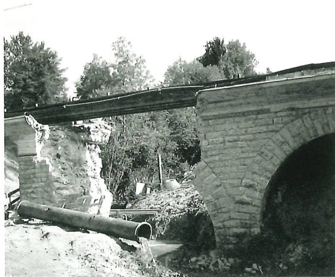
△ △ Ausbau der S-Bahnlinie auf Doppelspur zwischen Meilen und Uetikon, provisorische Brücken über die Dollikerstrasse, links, und über den Gruebweg und den Inneren Dollikerbach, rechts.
