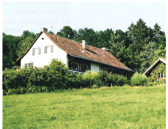
Das obere Bauernhaus in der Breiti, jetzt als Wohnhaus eingerichtet.
