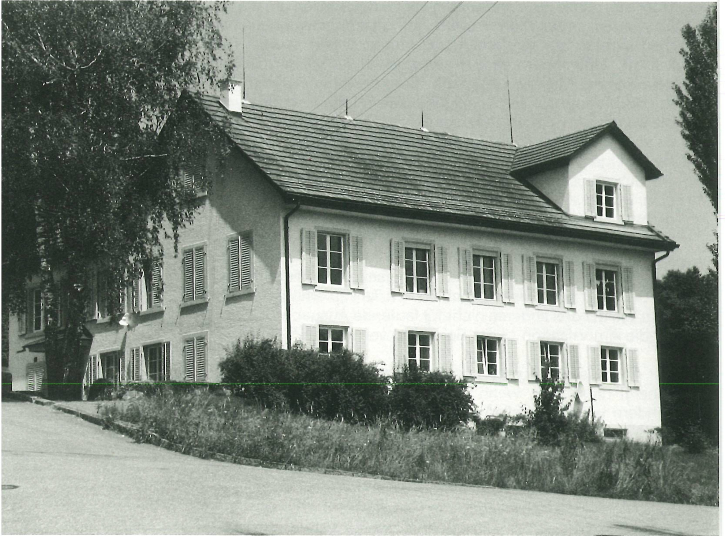
Das Schulhaus Bergmeilen, erbaut 1846 (Südwestecke).
