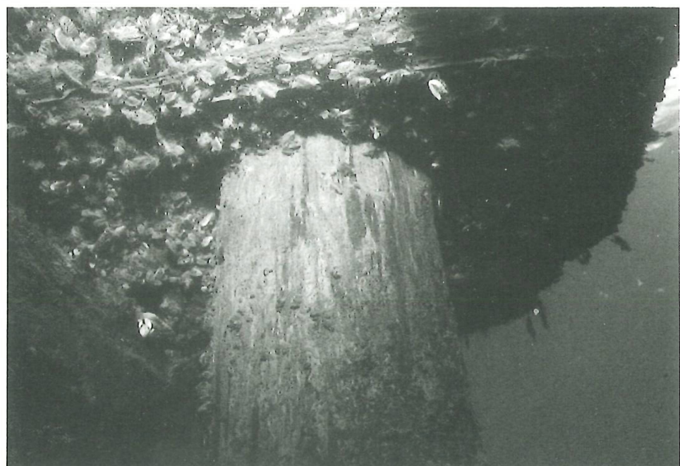
Von Muscheln befallener Funda- tionspfahl in der Löwenhaab.
