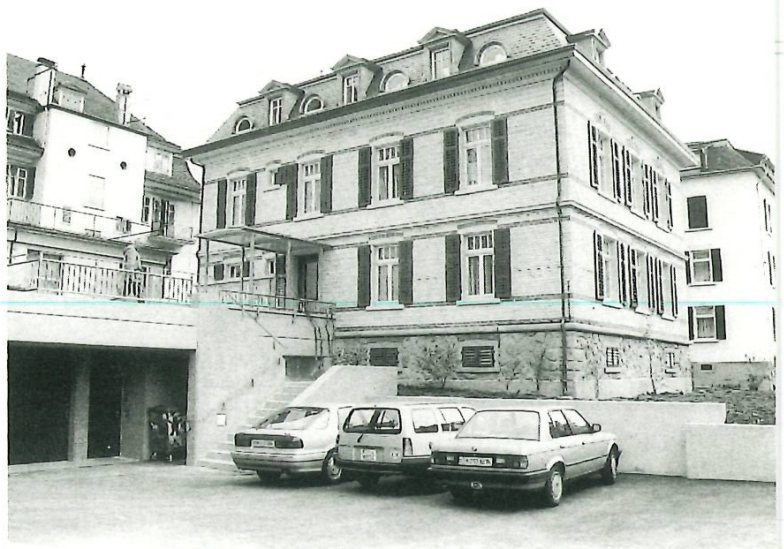
Das renovierte Bauamt, Bahnhofstrasse 35, Südwestansicht, und die neu eingerichteten Arbeitsplätze des Vermessungsamtes.
