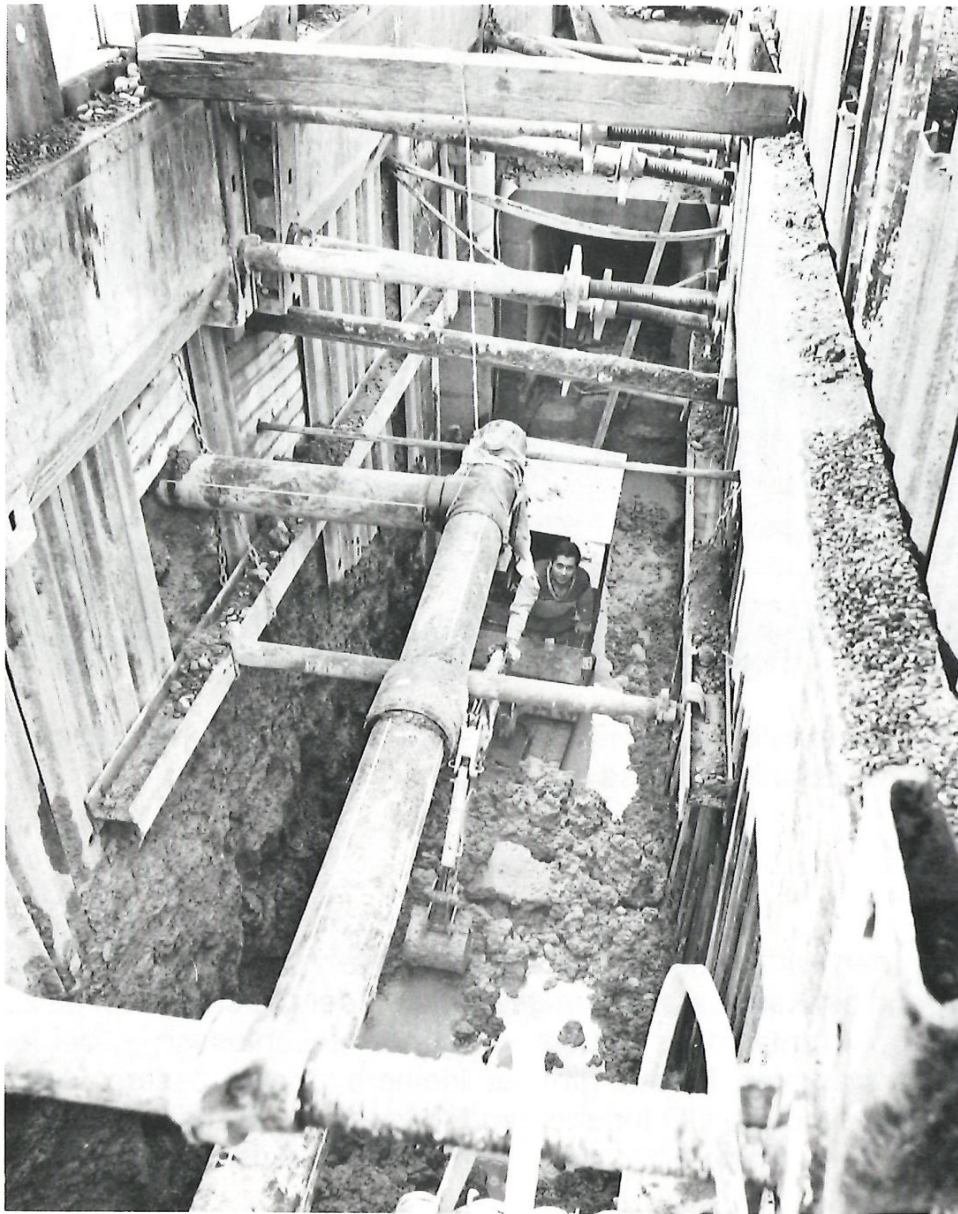
Kanal in der Bruechstrasse. Er wird Kabel und Leitungen für Wasser, Abwasser, Strom, Gas usw. aufnehmen. Der Schutz der Arbeiter ist sehr wichtig.
