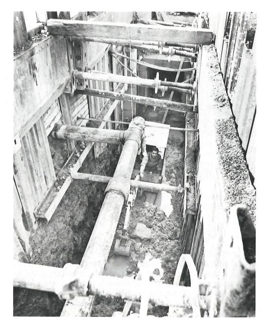
Kanal in der Bruechstrasse. Er wird Kabel und Leitungen für Wasser, Abwasser, Strom, Gas usw. aufnehmen. Der Schutz der Arbeiter ist sehr wichtig.
