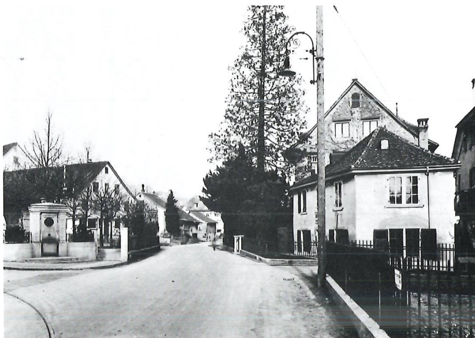
Waschhaus und Nordwestgiebel, 1924.
