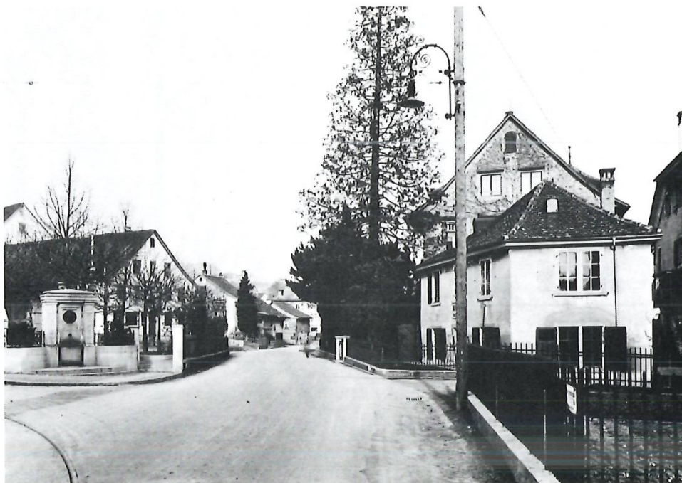
Waschhaus und Nordwestgiebel, 1924.
