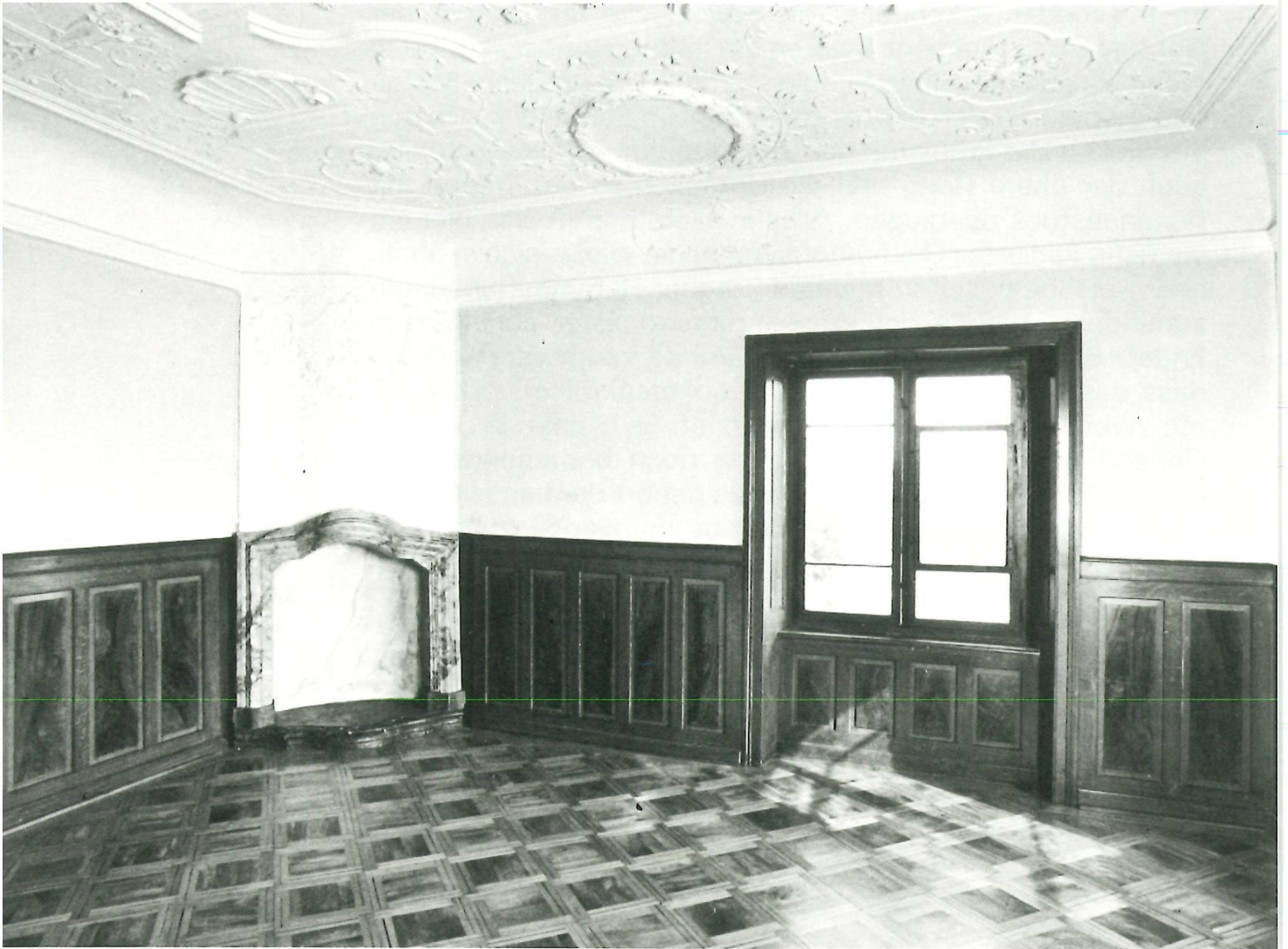
Der südliche Teil des Saals im 2. Obergeschoss. Dem Cheminée liegt ein gleiches gegenüber in der Nordecke.
