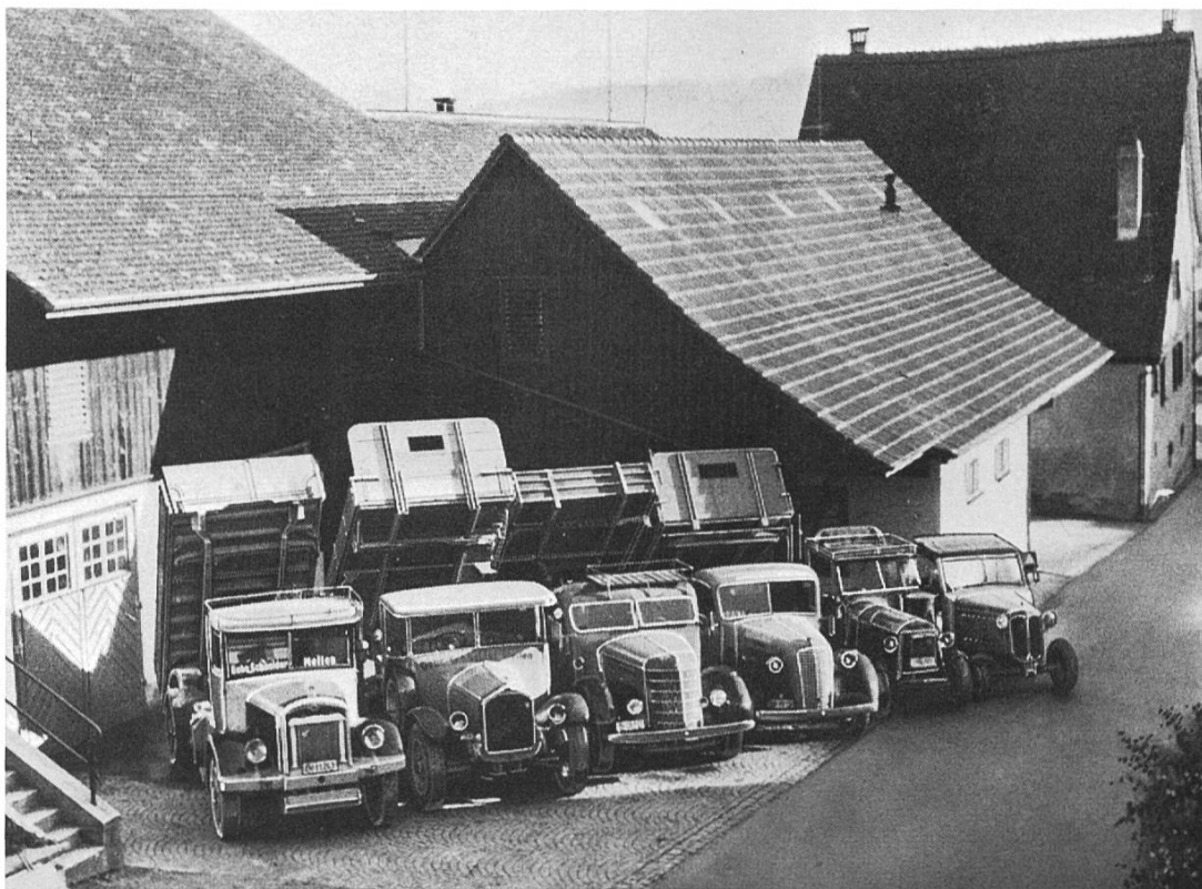
Wagenpark an der Rosengarten- strasse, 1940, davon sind drei Holzgaswagen.
