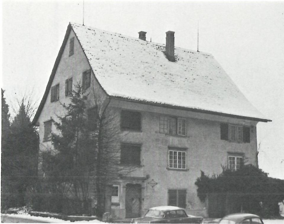
«Sonnenhof» oder «Junker- haus», ehemali- ges Herrschafts- haus vor dem Abbruch.
