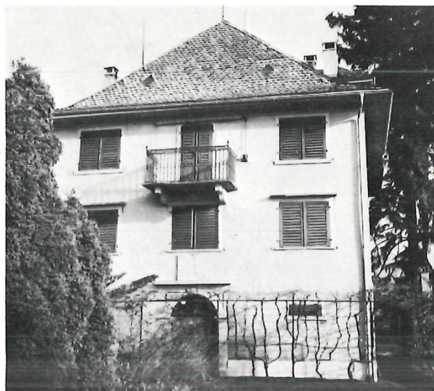
Heutiger Zustand der Seefassade.
