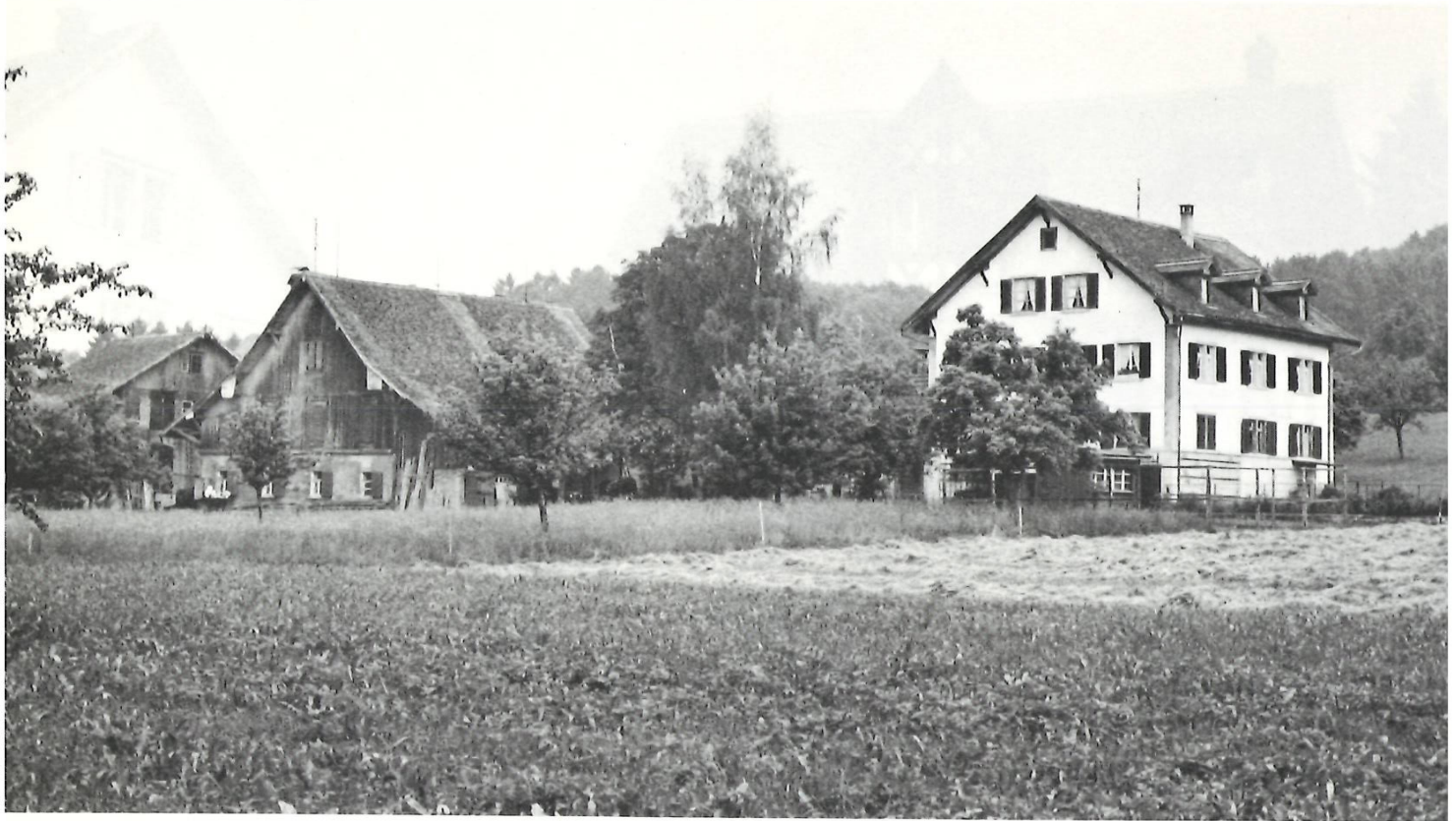
Der Hof Lienberger mit den Gebäuden aus der zweiten Hälfte des letzten Jahrhunderts.
