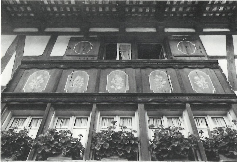
Die Falläden an den Fenstern der seeseitigen Stube mit späterer Bemalung.
