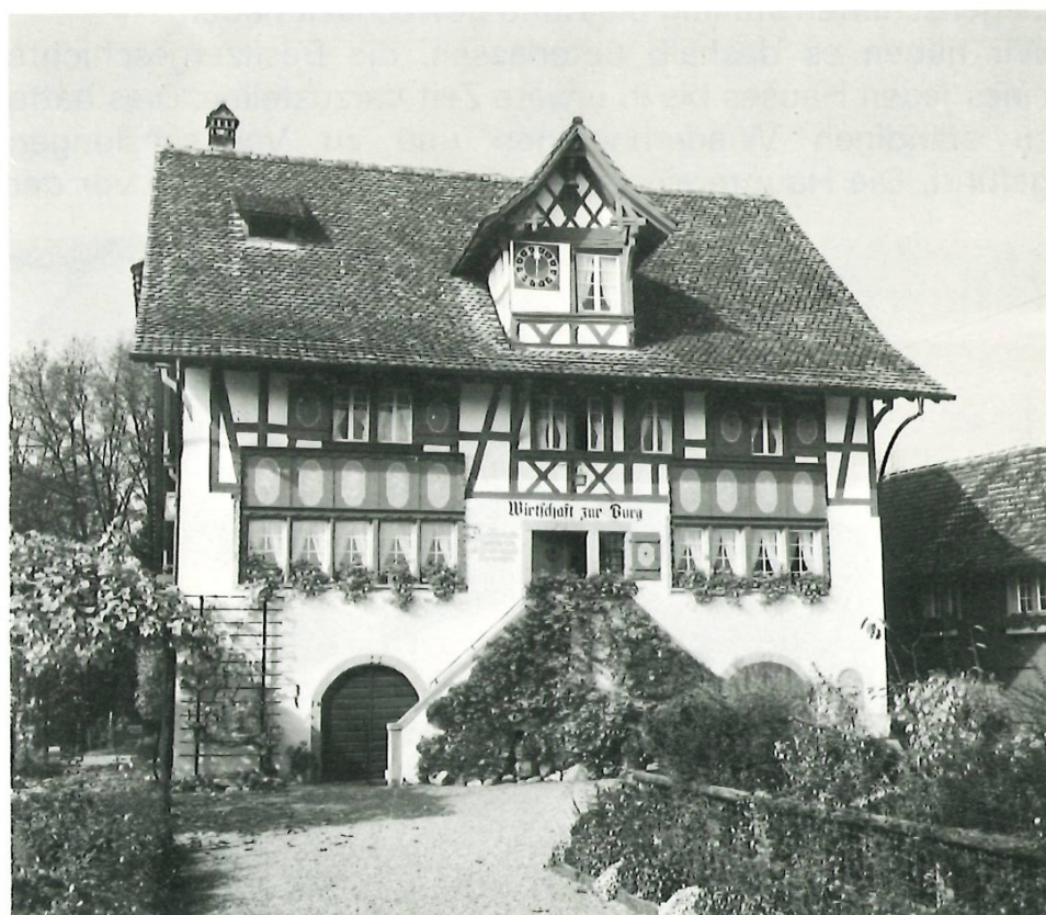
Das Haus (zur Burg) im heutigen Zustand, Aufnahme der Hauptfront 1980.
