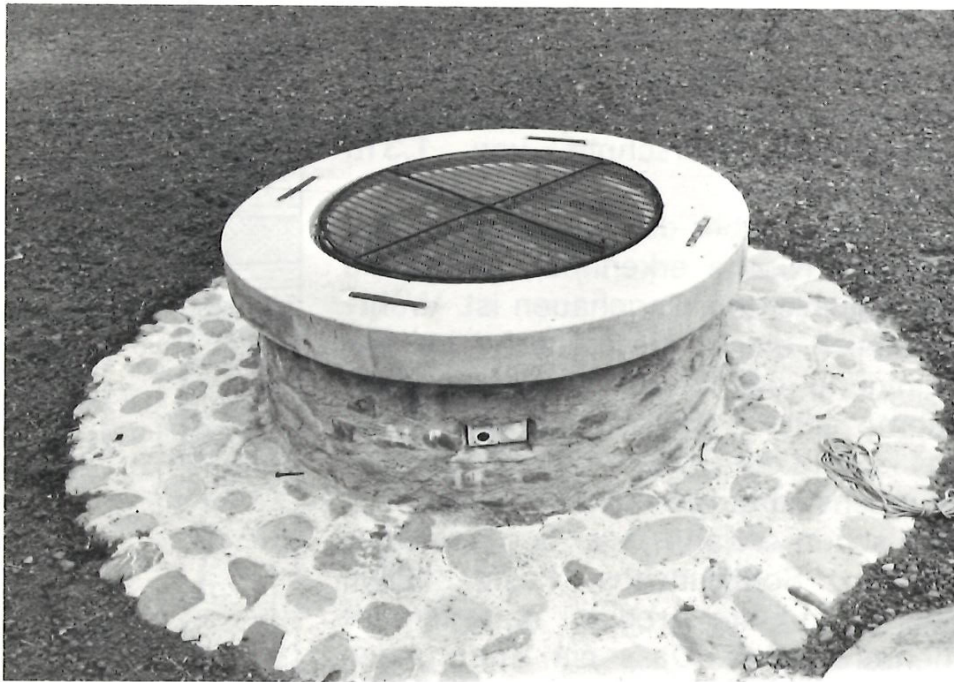
Abb.28 Der wiederaufgemauerte Brunnenkranz auf dem Sodschacht.
