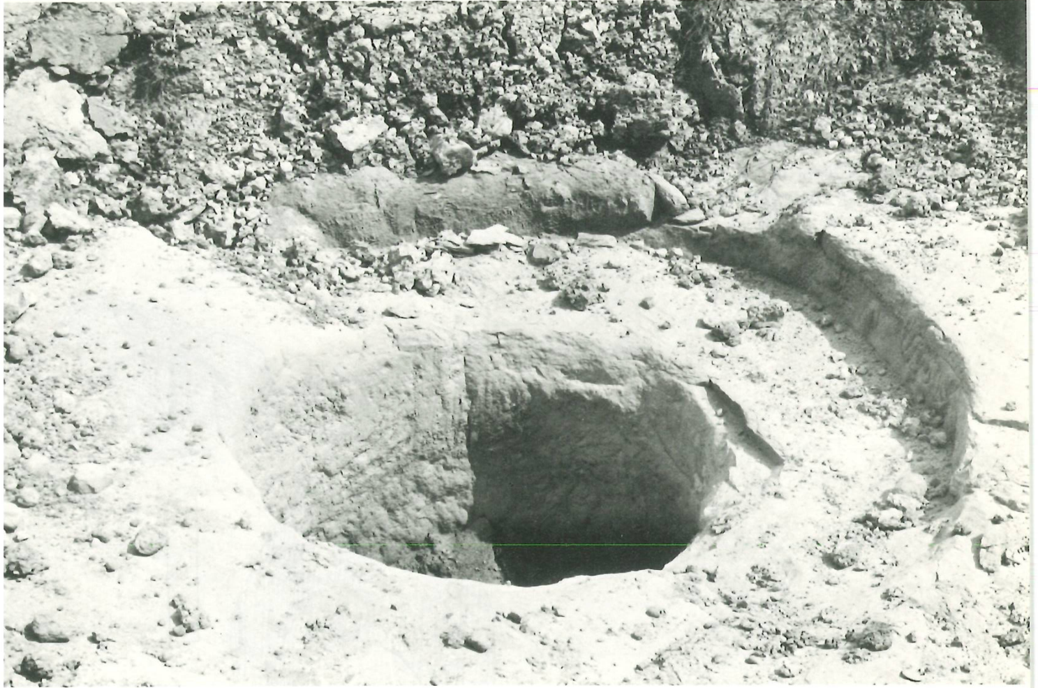
Sodbrunnen. Deutlich sichtbar ist das in den Sandstein gehauene Fundament für den Mauerkranz.
