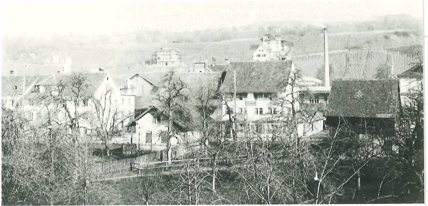
Blick vom Obstgarten Hüni auf die alte Landstrasse mit dem Restaurant «Schützenhaus» in der Bildmitte. Links daneben das Spritzenhaus
