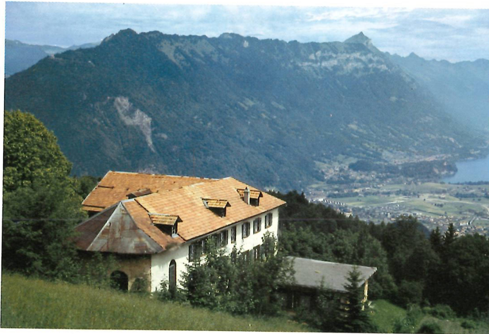
Der Abendberg mit nach hinten angebaute Kapelle. Blick gegen Interlaken und Brienersee (Aufnahme 1979).
