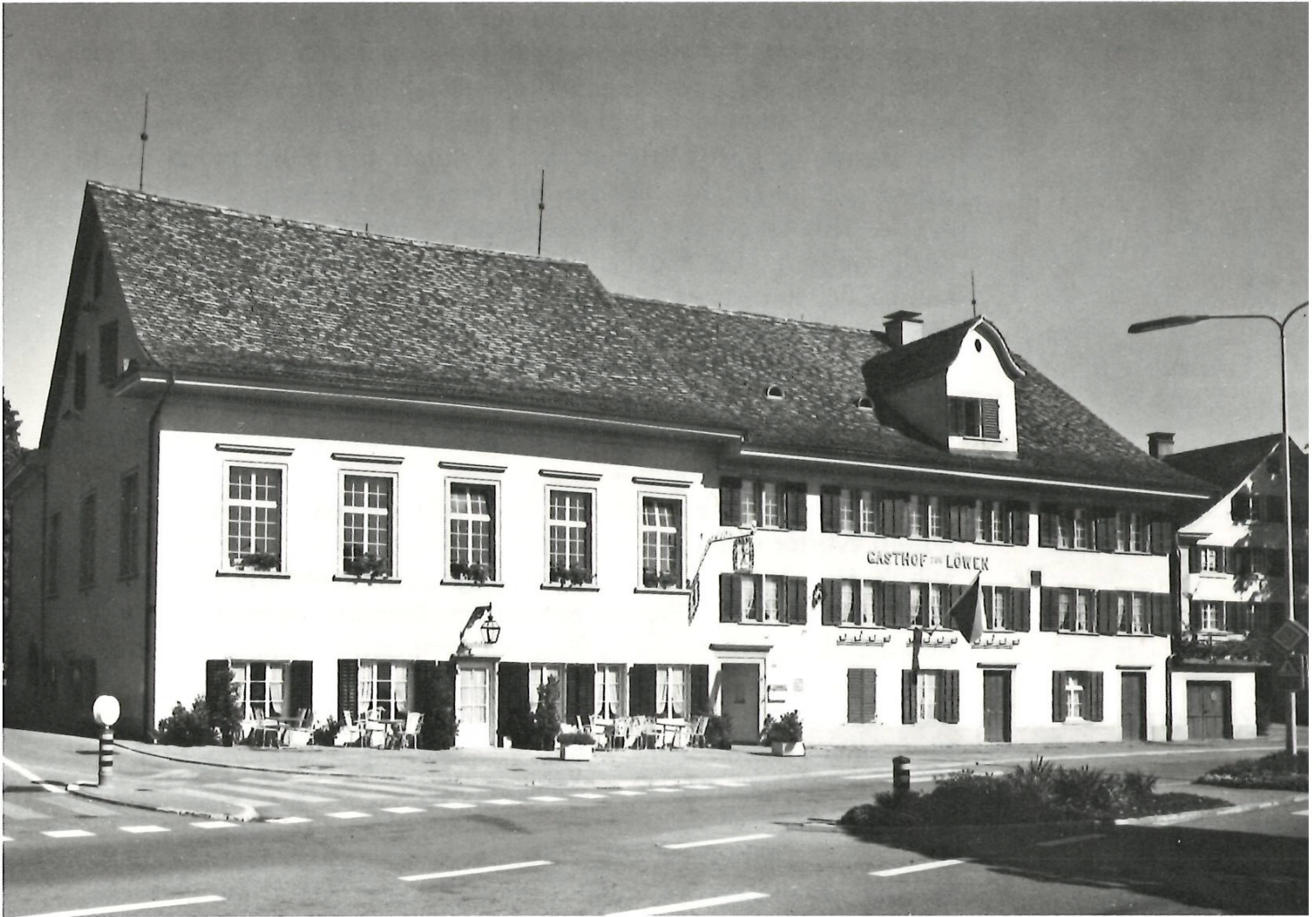
Oben und rechts: Der gemeindeeigene Gasthof «Löwen» nach der Renovation des Saals und des Parterre-Restaurants (beide im Hausteil links)
