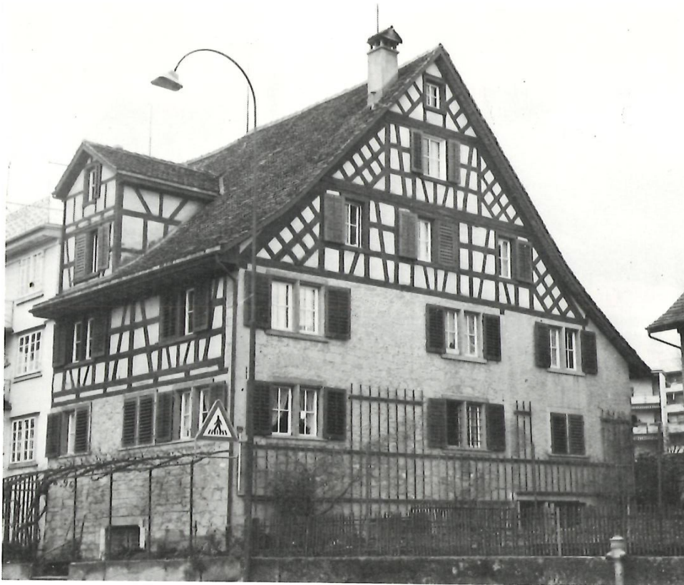
Doppelhaus See- strasse 825, Ober- meilen, datiert 1774, mit Sicht- mauerwerk
