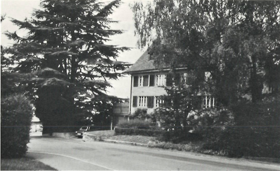
Haus Bünishof in Feldmeilen Ostseite
