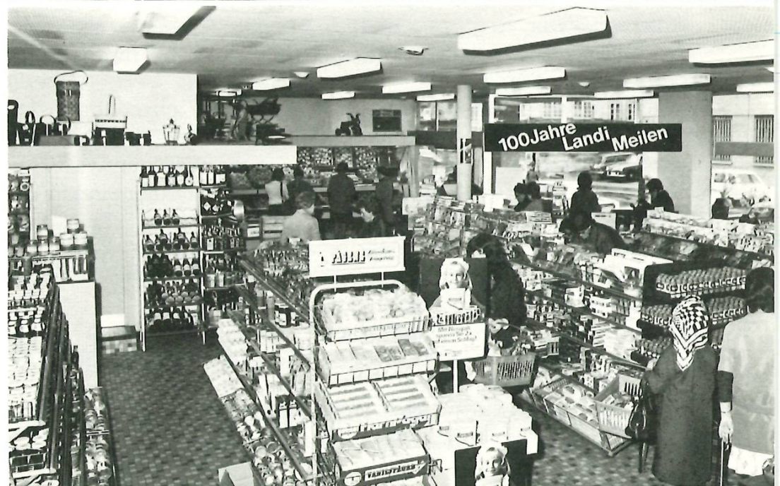
Selbstbedienungsladen im neuen Verwaltungsgebäude, eröffnet 1961.
