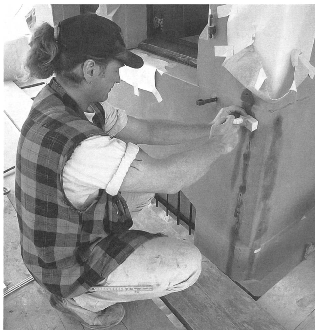
Mitarbeiter der Münsterbauhütte greifen für die Sanierung des Sandsteins am Torturm zur Injektionsspritze.
