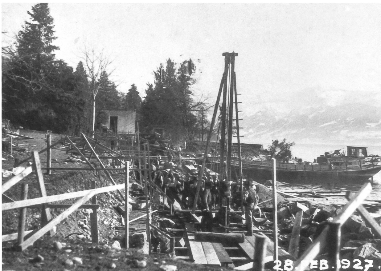
Neubau eines Teils der heutigen Ufermauer nach dem Einbruch des Sees bei der «Kuhtränke». Aufnahme vom 28. Februar 1927
