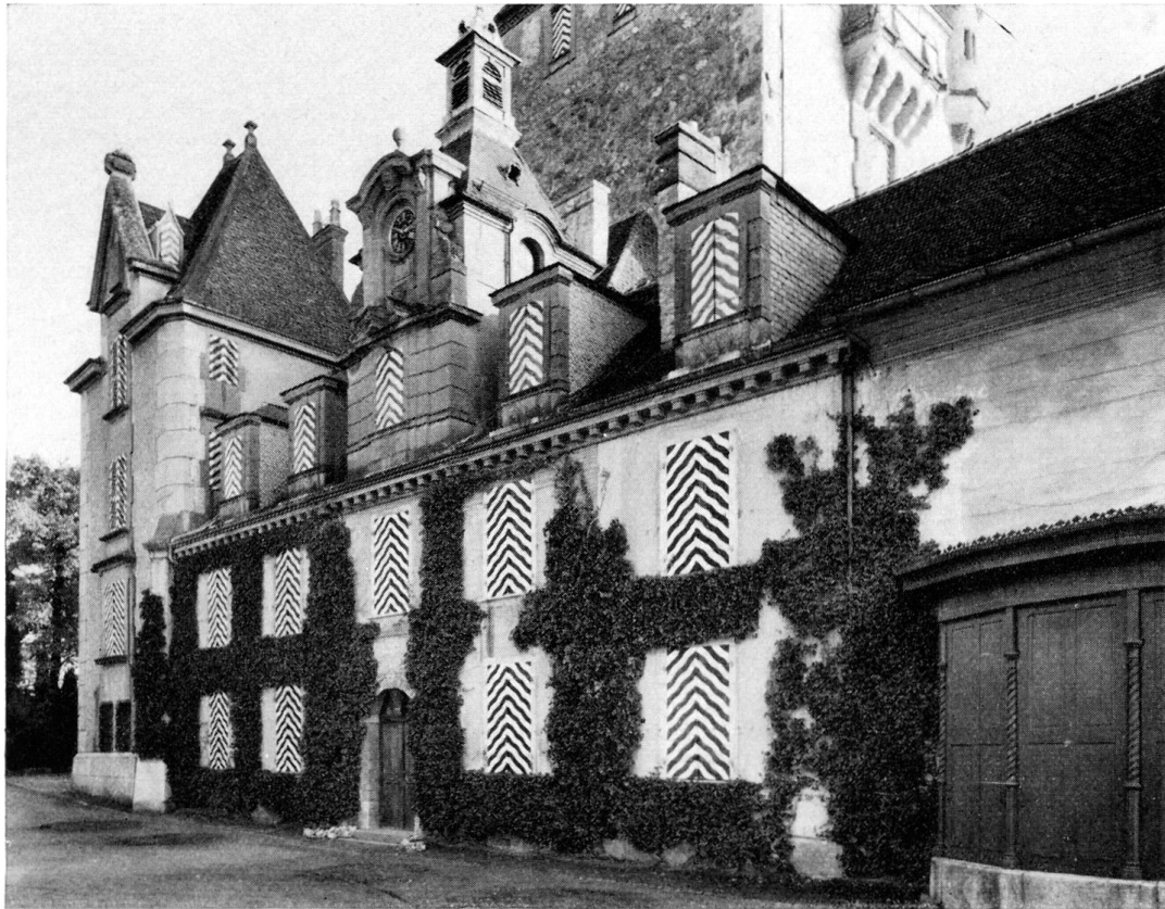
Abb. 6. Schloß Oberhofen, Hoffassade, vor der Restaurierung
