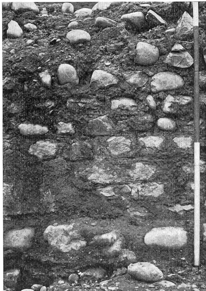
Abb. 8. Arenamauer 3 m Nord von P4. Unten: Vorfundament und Arenaboden, darüber: Mauer mit Fugenstrich, und links: Grob- mit überlagerndem, bemaltem Feinputz. M. etwa 1:11.
