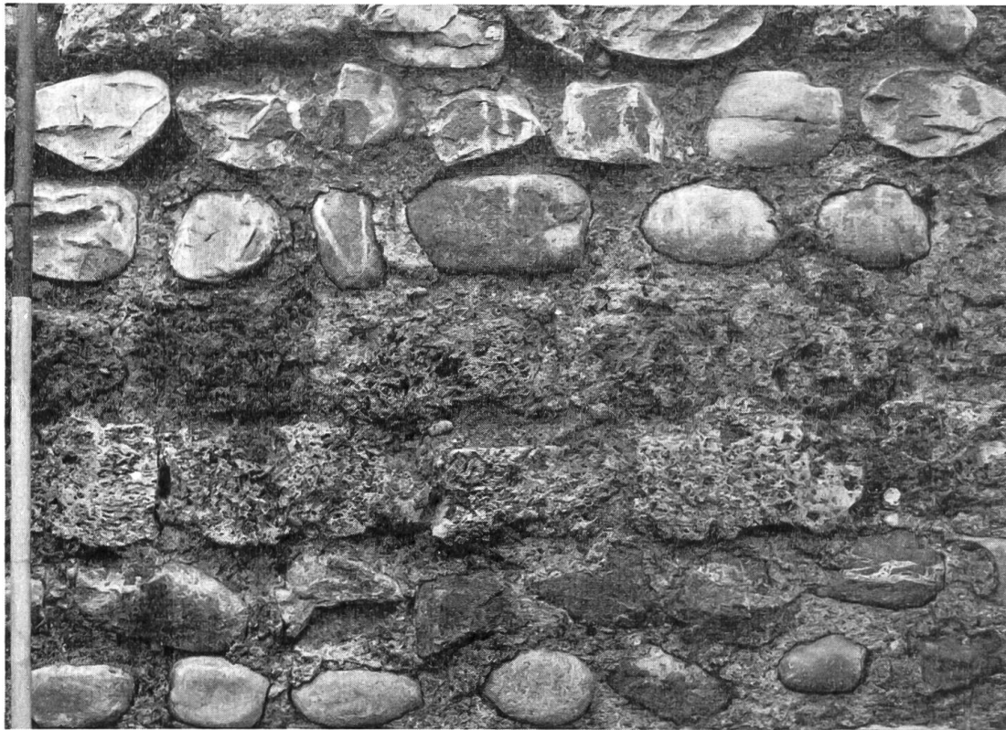
Abb. 7. Doppelreihe von Tuffsteinquadern in der Rückwand des östlichen Trapezanbaues und zur Fluchthaltung behauene Geschiebe. M. etwa 1:9.
