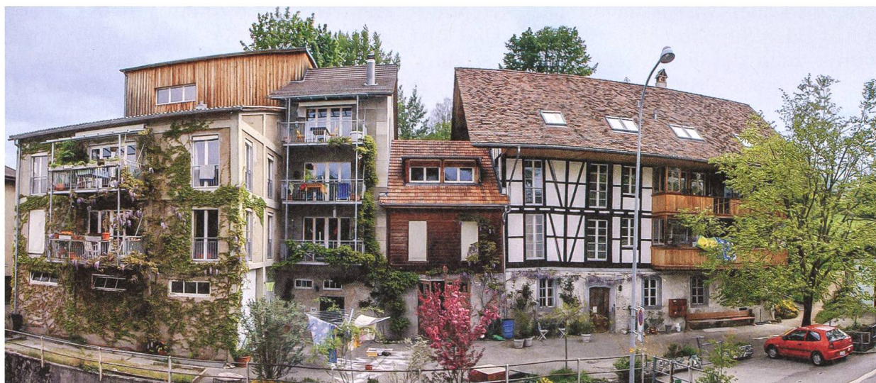
Die ehemalige Schlossmühle (rechts) mit umgebautem Siloteil (Beat Christ)
