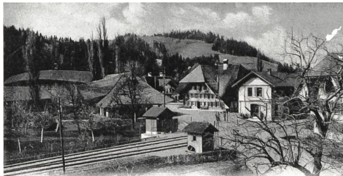
Der Bahnhof Zollbrück entstand 1881 mit dem Bau der Emmentalbahn. Links auf der Postkarte sieht man die alte Holzbrücke, die am 1. August 1947 abgebrannt ist.
