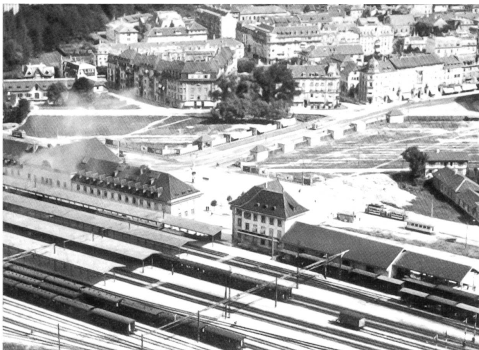
Der neue Bahnhof nach 1923. Im Hintergrund sind noch Spuren des vorherigen Bahnhofs zu erkennen, dessen Terrain in der Folge überbaut wurde. (Stadtarchiv Biel)
