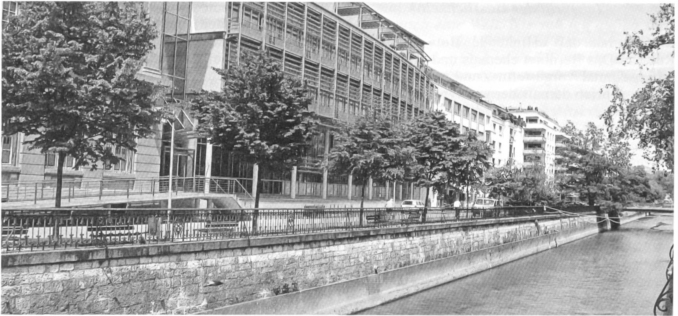
Schüsskanal mit dem Erweiterungsgebäude der UBS (1996) (Foto Markus Lehmann)
