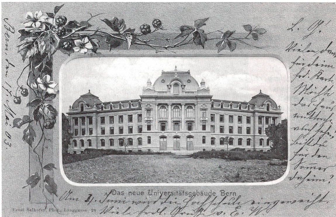
Das Universitätsgebäude auf der Grosse Schanze in Bern, kurz nach Fertigstellung im Jahre 1903
