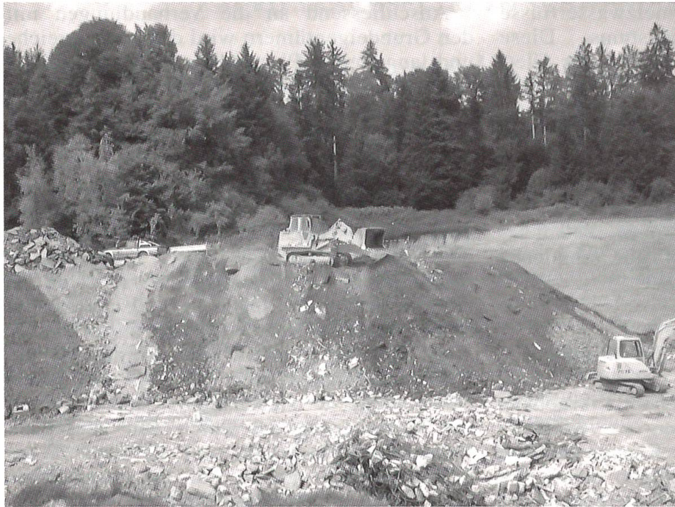
Deponie für Aushubmaterial der KAGA
