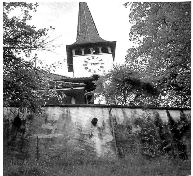
Diese hohe Stützmauer entstand, weil 1709 das Niveau für den Neubau der Kirche wegen einer Auffüllung um vier Meter angehoben worden war.
