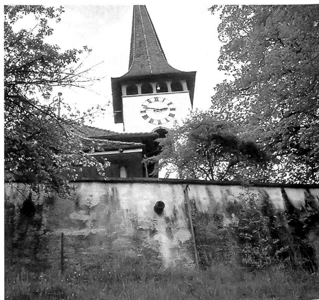
Diese hohe Stützmauer entstand, weil 1709 das Niveau für den Neubau der Kirche wegen einer Auffüllung um vier Meter angehoben worden war.
