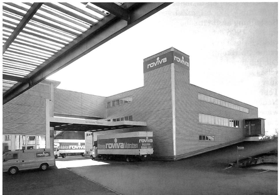
Speditions- und Lagerhalle mit 5-Tonnen-Lift
