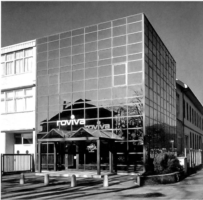
Das Verwaltungsgebäude nach Plänen des Corbusier-Schülers Alfred Roth
